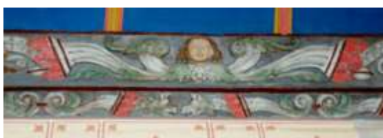
◀ Détail des sablières
